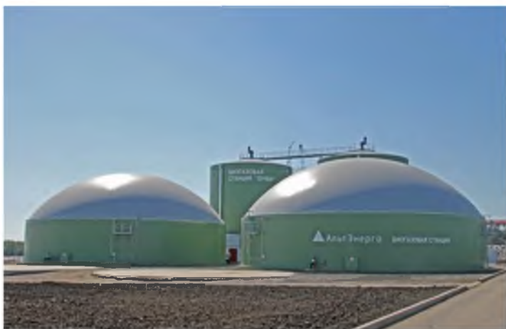
Рис. 4.14. Биогазовая станция «Лучки»
